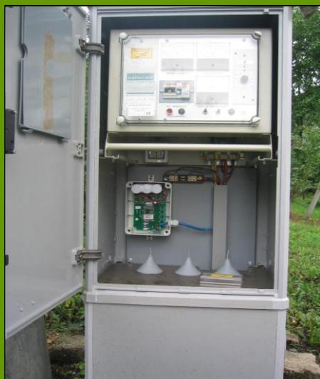
Il sistema di telecontrollo, nelle Stazioni di alimentazione, è in grado di controllare i valori della tensione e della Corrente erogata oltre che a controllare la Differenza di Potenziale tra tubo e terra.
